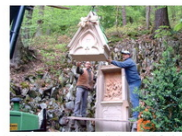
Aufsetzen der restaurierten Haube an der III. Station
